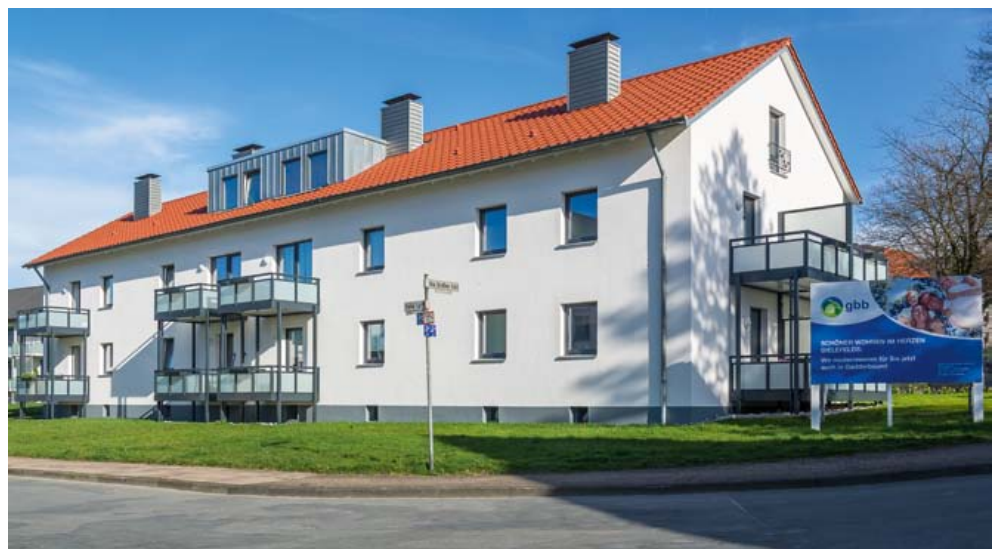
Modernisierungsmaßnahme Am Großen Feld 7-9 – Foto: Gábor Wallrabenstein
