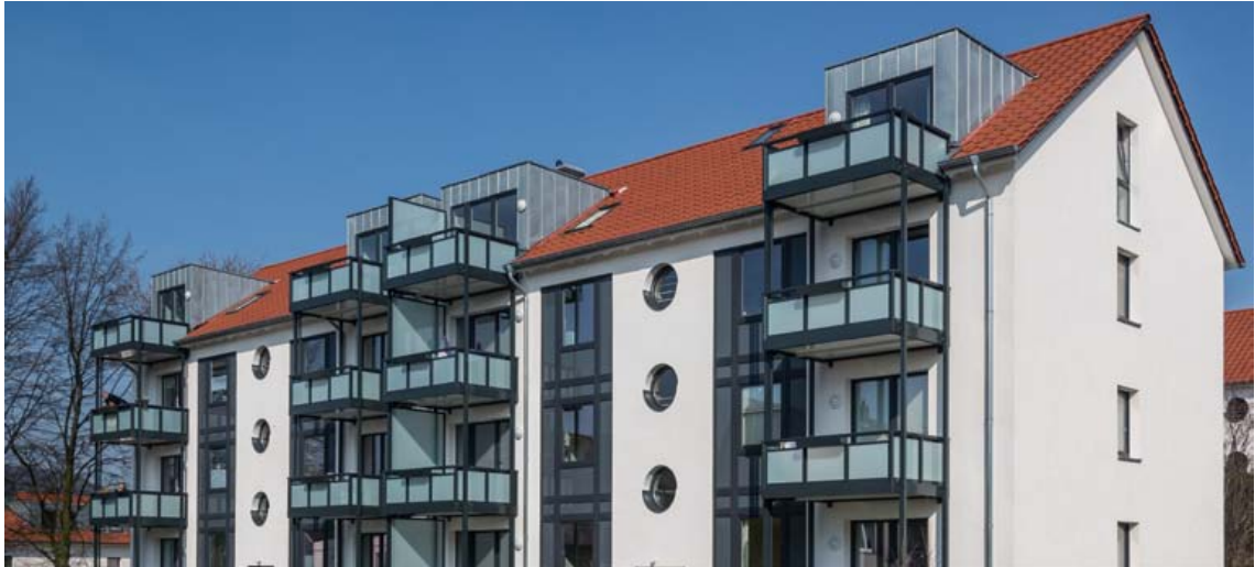
Modernisierungsmaßnahme Am Großen Feld 17-19 – Foto: Gábor Wallrabenstein
