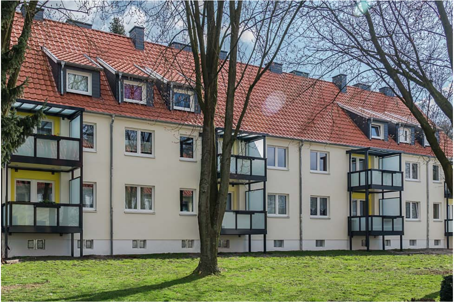
Modernisierungsmaßnahme Westfalenstr. 28-30 A – Foto: Gábor Wallrabenstein
