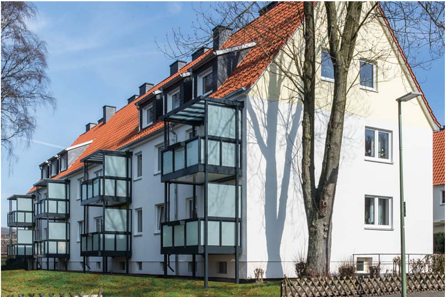
Modernisierungsmaßnahme Westfalenstr. 28-30 A – Foto: Gábor Wallrabenstein
