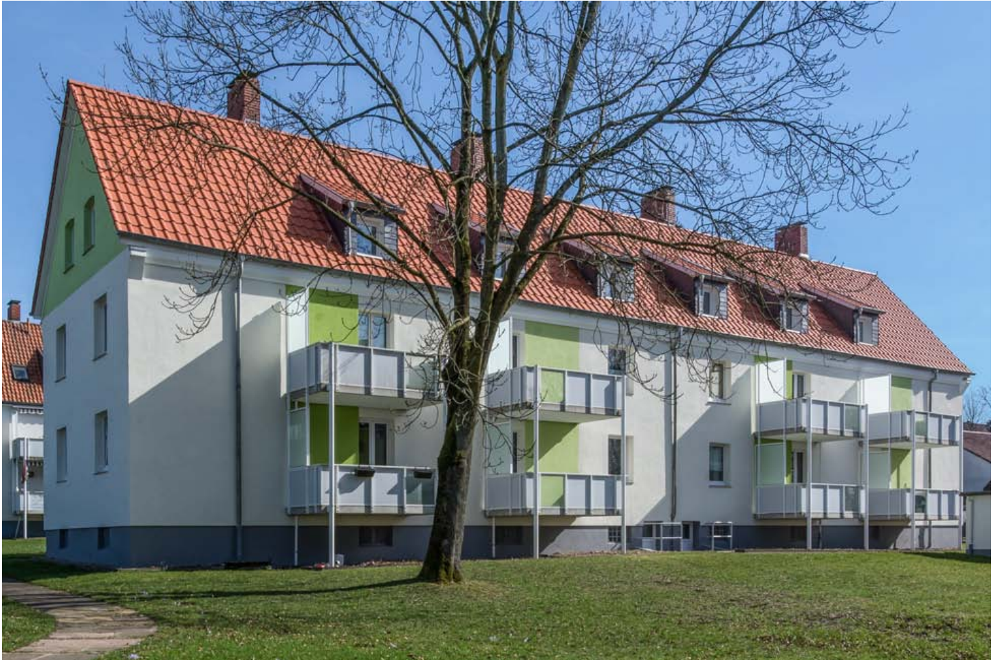
Modernisierungsmaßnahme Westfalenstr. 24-24 A – Foto: Gábor Wallrabenstein
