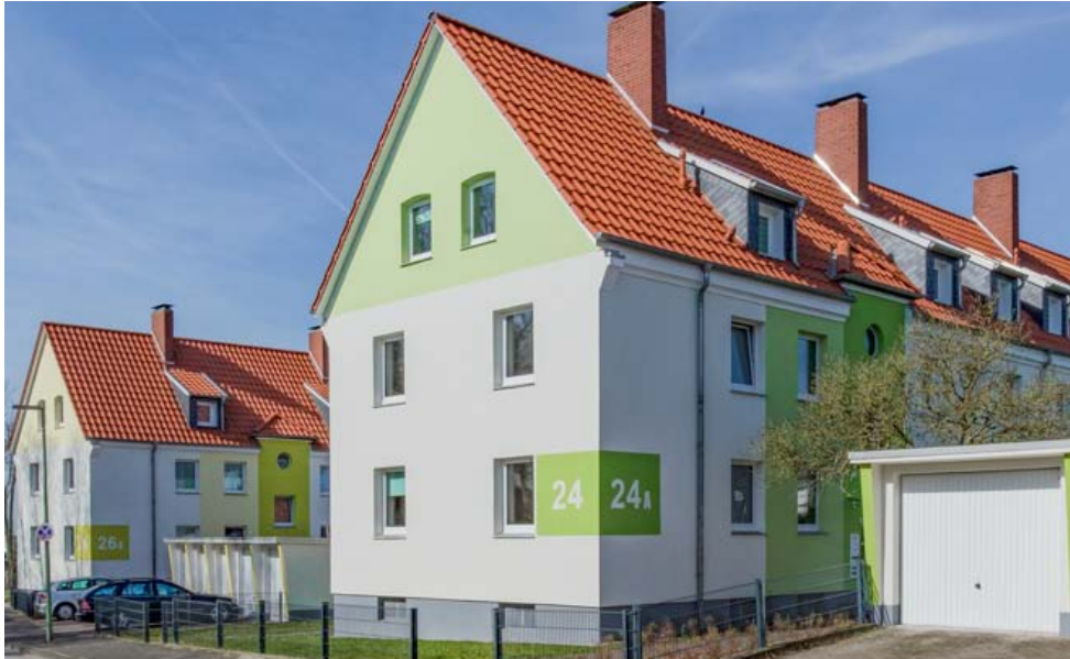
Modernisierungsmaßnahme Westfalenstr. 24, 24 A und 26, 26 A – Foto: Gábor Wallrabenstein
